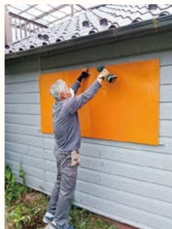
くらし支援サービスによって派遣された 職員が強風によって壊れてしまった自宅 の窓ガラスの応急処置を施しました。
